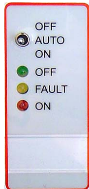
Fan Control Unit
